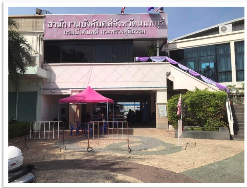
ภาพที่ 1-1 อาคารสำนักงานบังคับคดี
