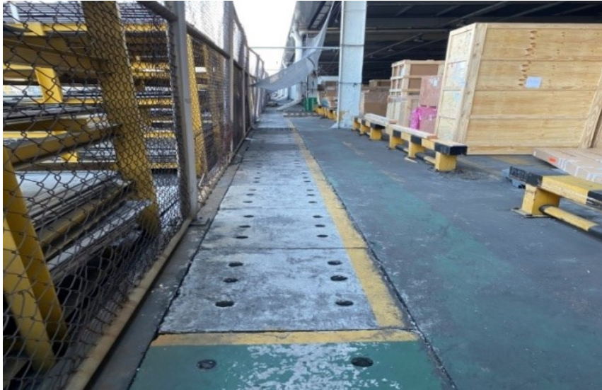
รูปที่ 2.5 ทางเดินที่ปลอดภัยเนื่องจากได้รับการแก้ไขแล้ว
